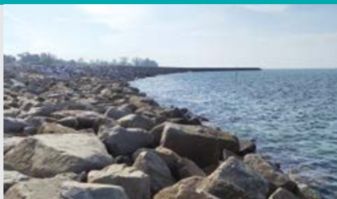
Benteng pemecah ombak Pantai Tok Jembal di Kuala Terengganu (Terengganu).
