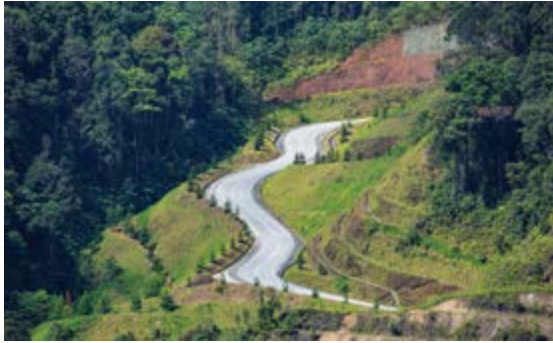
Foto 8.9 Pembinaan jalan raya
