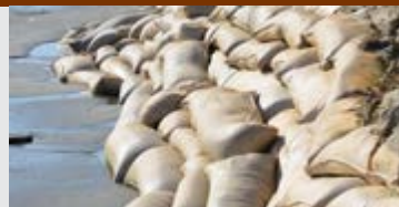
Guni pasir digunakan untuk menahan hakisan ombak di tepi pantai.
